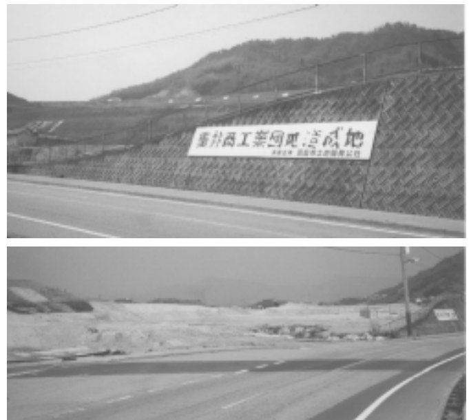
今年度中に分譲が開始される重井工業団地造成地
