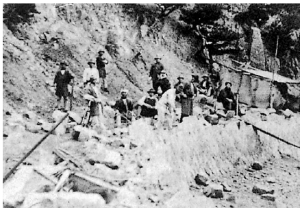
大浜村、海岸道路建設(大正11年)
