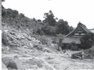
崩れた重井町善興寺墓所
