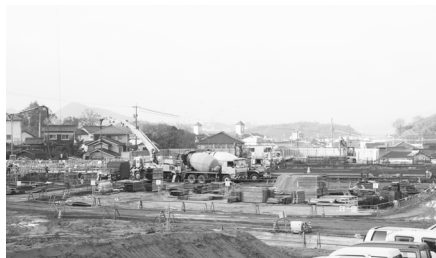
現在の工事状況
